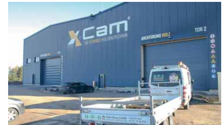
Die 2021 errichtete Produktionshalle von X-Cam liegt im Gewerbegebiet von Kall. (Foto: St. Klein)
