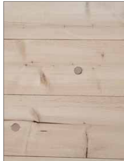
An einigen Wänden ist das „Nur-Holz“-System mit seinen typischen Buchenholzverbindungen erkennbar.
