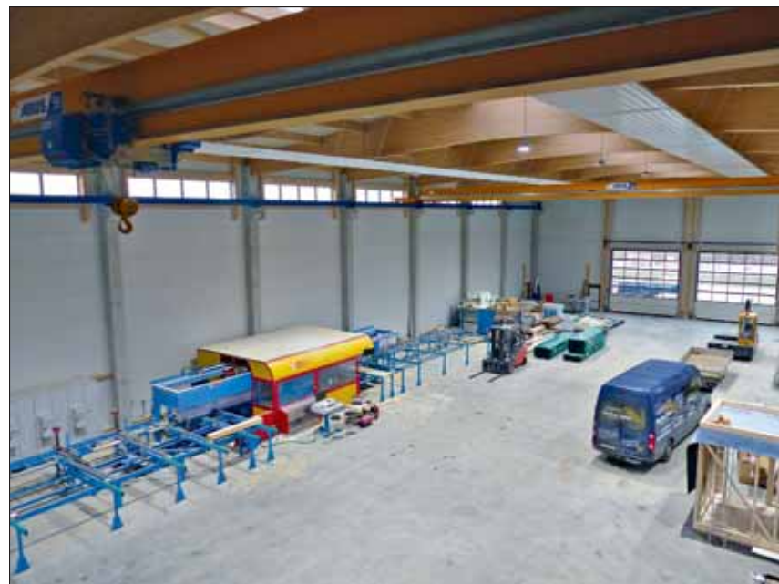
Prunkstück in der hohen Abbundhalle ist eine Hundegger „K2 Industry“. Die Halle wird von der Decke her beheizt, also nicht über eine Betonkernaktivierung, um auch in Zukunft bei der Aufstellung von Maschinen flexibel zu sein.
