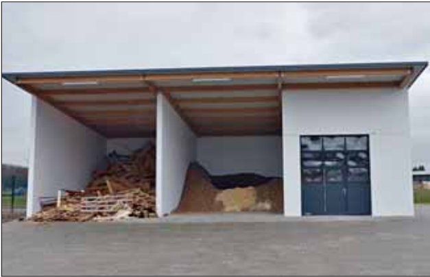
Die Späne aus der Absaugung landen per Lader direkt im Bunkerteil neben dem Kesselraum (rechts), stückiges Restholz wird daneben gesammelt und bei Bedarf von einem externen Unternehmer gehackt und zu den Spänen geblasen.
